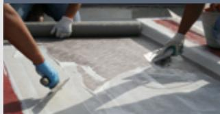
Kimicover GUAINA es un sistema de impermeabilización cementoso bicomponente y superelástico. De alto rendimiento y versátil, produce una película compacta con una excelente adherencia. Normalmente para ser alicatado, también se puede proteger con Kimicover BLINDO.
