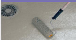
Kimicover 601P es un revestimiento líquido de poliuretano, monocomponente y de base disolvente. Es un producto impermeabilizante versátil que puede utilizarse en cualquier soporte, incluso sin refuerzo.
