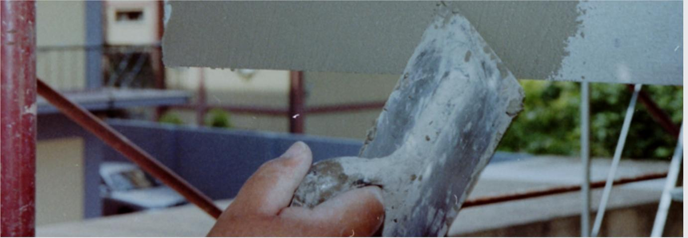
Una intervención de restauración del hormigón también puede implicar elementos no estructurales o incluir una serie de operaciones de acabado que, si no se realizan correctamente, pueden comprometer el resultado de la restauración. En esta categoría se incluyen los morteros cementosos con propiedades mecánicas más bajas que los de uso estructural.
