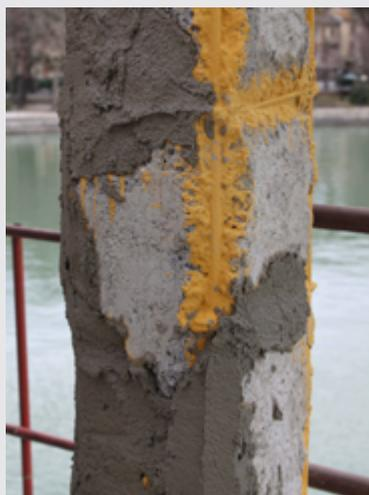
Actualmente, las soluciones de Kimia para la restauración de elementos estructurales de hormigón incluyen **ciclos especializados** en los que se utilizan varios productos juntos, cada uno con su propia función, y **ciclos simplificados** que utilizan soluciones que realizan varias funciones, reduciendo así el tiempo de aplicación. Este último caso incluye nuestros morteros Betonfix MONOLITE N y R.
