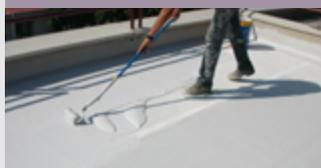
Kimicover 501 es un revestimiento líquido monocomponente en dispersión acuosa a base de elastómeros acrílicos. Ideal para la impermeabilización en frío de cubiertas de cualquier soporte, incluso en presencia de membranas bituminosas existentes.
