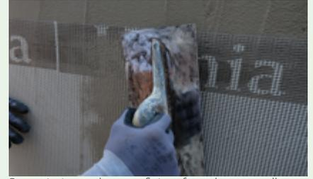
Revestimiento de superficie reforzado con malla de vidrio
