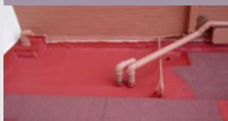
Kimicover LASTIC es un revestimiento líquido monocomponente en dispersión acuosa a base de elastómeros acrílicos. Se utiliza para impermeabilizar cubiertas de diferentes soportes (hormigón, ladrillo, fibrocemento, madera) con buena adherencia.
