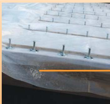
Una lona transpirante impermeable previene la percolación de mortero de cemento, la absorción de agua del chorro por parte de la madera y la fastidiosa formación de polvo en las superficies situadas debajo. Se extenderá en contacto con la madera, debajo de los conectores.
